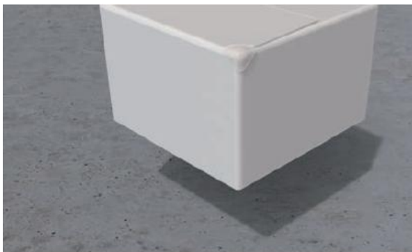
f) Zaštitni kut pažljivo pritisnuti na podlogu
