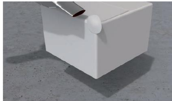
e) Zaštitni kut lagano zagrijati toplim zrakom
