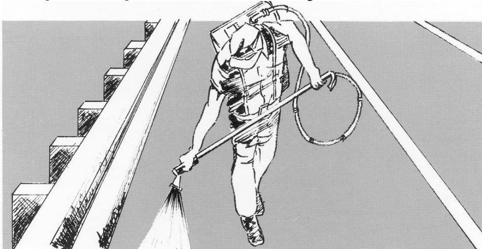
Pokrivenost proizvoda Radcona # 7 bi trebala prosječno iznositi 1 litra za 5 m<sup>2</sup> površine. Na poroznim i grublјim površina potrošnja će biti veća, a na glatkim i čvršćim betonima potrošnja je manja, 1 litra za 6 m<sup>2</sup>.
